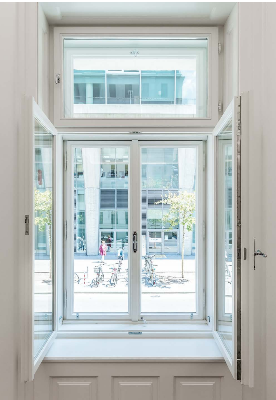
Referenzobjekt Geblergasse: Im 17. Wiener Gemeindebezirk finden sich gründerzeitlich geprägte Viertel, wobei es das historische Stadtbild zu erhalten galt (oben). Innenansicht eines zweiflügeligen Rahmenpfostenfensters mit Oberlichte (unten).
